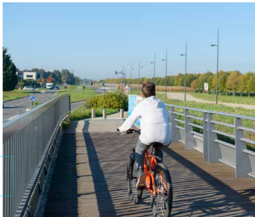
Des passerelles piétons-cycles franchissent l'autoroute A5.
