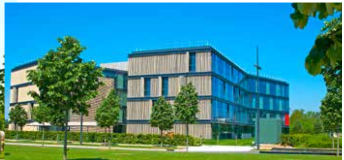
Les immeubles « Bambou 1 et 2 », programme de 7200 m 2 de bureaux, accueillent le Centre de Gestion de la Fonction Publique Territoriale de Seine-et-Marne (CGFPT 77) et EDF.
