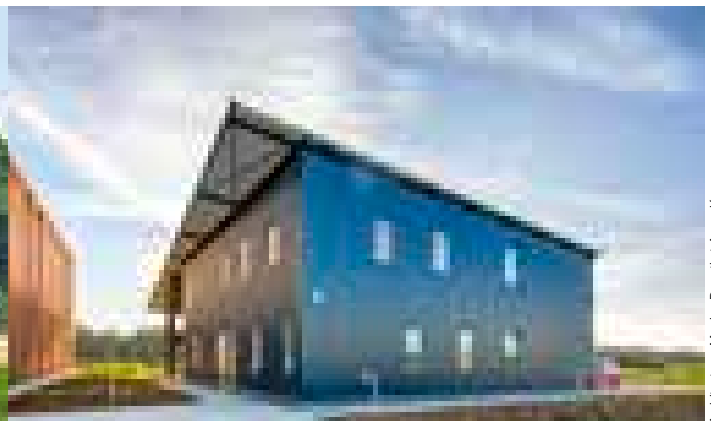
10 000 m 2 de locaux d'activités avec bureaux sont développés par Fulton (Livraison de la deuxième tranche en 2016).
