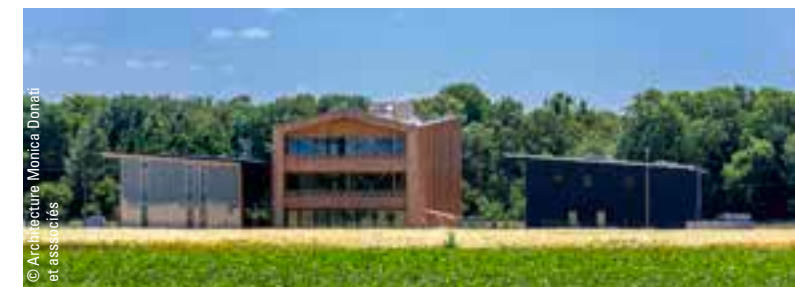
Greenpôle : locaux d'activités, de bureaux, une pépinière et résidence d'entreprises
