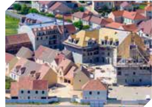
Perspective de l'opération Cœur de bourg menée par Les Nouveaux Constructeurs et la SOPPEC.
