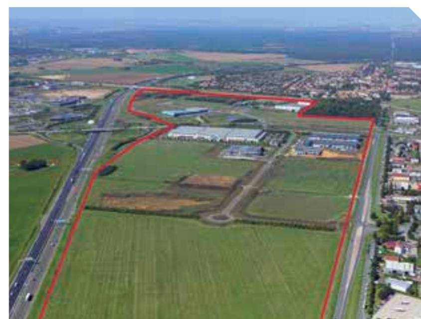
Des façades importantes sur l'autoroute A5a et la RD306.
