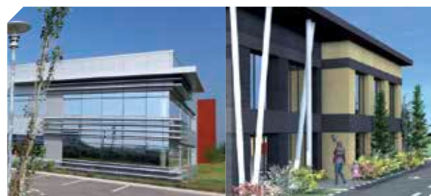
Périrpark, locaux d'activités à la location. Bâtiment passif BV Promo.
