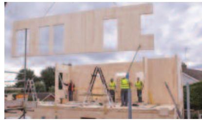
Référence Constructive CLT – SKONTO – Maison privée - UK
