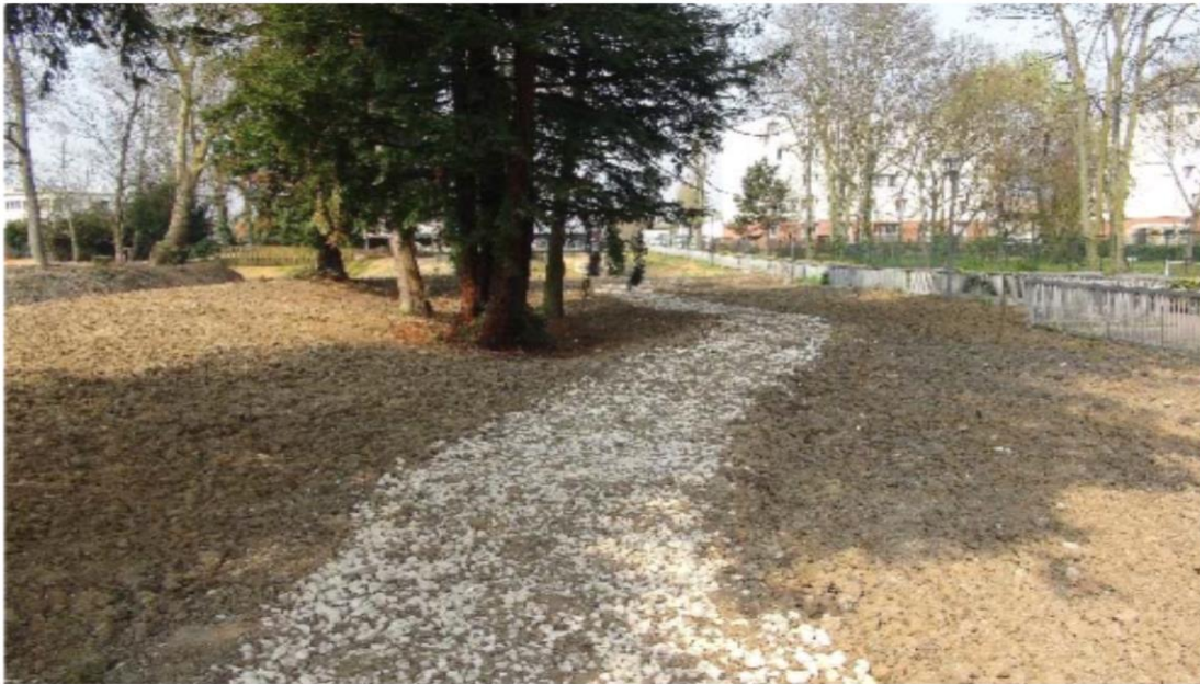
Exemple de cheminement en terre pierre réhaussé
