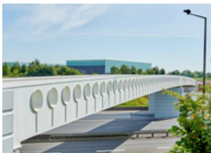
**5** Inauguration de la passerelle de l'AS : Cet ouvrage d'art de 100 mètres de long et 4 mètres de large, intégré à une voie cyclable de 2,4 km, a été réalisé par l'EPA Sénart pour relier le Carré Sénart et la gare RER de Lieusaint-Moissy. Dédié aux cycles et aux piétons, le projet dont le coût global s'élève à 4 millions d'euros est financé en partie par l'EPA Sénart.
