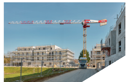
Le centre-ville de Cesson redynamisé avec la construction de 415 logements, Cesson (77).
