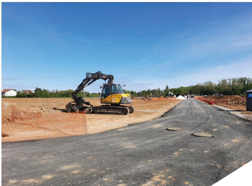
Travaux d'aménagement de la voirie, lot Mercure, Nandy (77).
