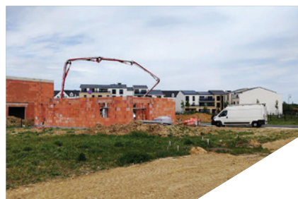
Travaux réalisés par l'EPA Sénart, Clos Maryse Bastié, Tigery (91).
