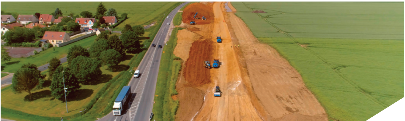
Travaux de réaménagement de la RD 57, entrée de bourg de Réau (77).
