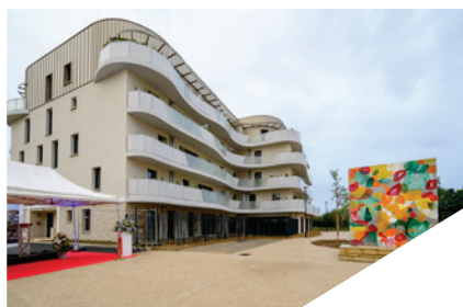
Programme immobilier Mycélium de Bouygues Immobilier réalisé par Emmanuel Gutel, alliant Logements collectifs et maisons individuelles, Moissy-Cramayel (77).
