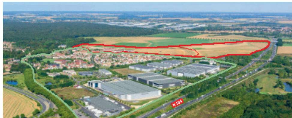
Une façade unique le long de la Francilienne.
