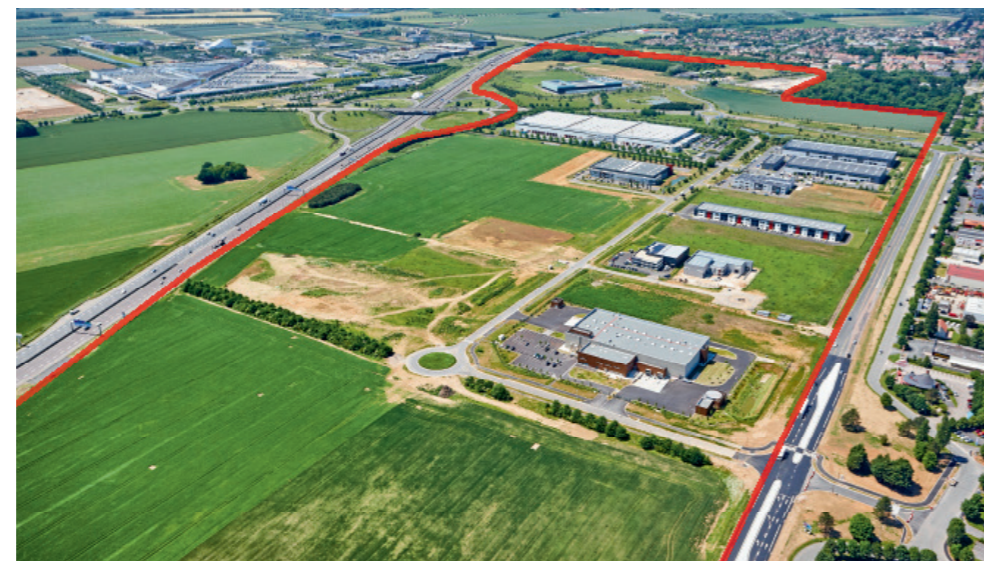
Les nouveaux aménagements réalisés par l'EPA Sénart permettent une seconde accessibilité du parc depuis la RD306 (ex RN6).
