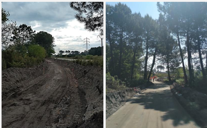
Photo de la piste cyclable avant et après mise en place de la couche de forme
