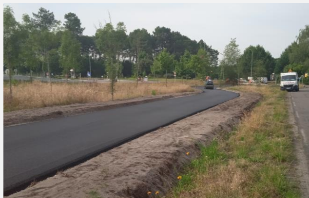
Etude de formulation dédiée à la technique routière pour la valorisation des sédiments du Bassin d'Arcachon – chantier expérimental sur le Bassin d'Arcachon
