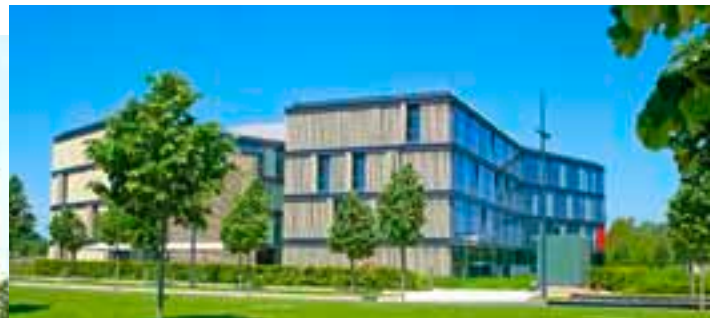
Les immeubles « Bambou 1 et 2 », 1 res tranches d'un programme de 11 000 m 2 de bureaux accueillant le siège social du Centre de Gestion de la Fonction Publique Territoriale de Seine-et-Marne (CGFPT 77) et EDF.
