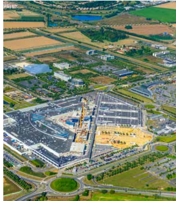
Extension du centre commercial Carré Sénart Ouverture octobre 2017.
