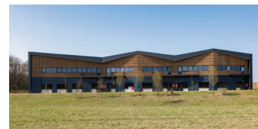
Parc Spirit Entreprises sur le parc du Charme.
