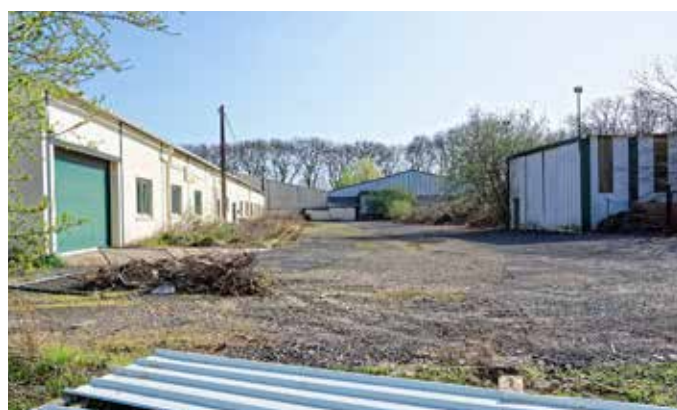
La friche industrielle de Bouzigues à Réau.
