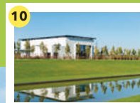
10 LE PÔLE ENSEIGNEMENT LE LYCÉE PRIVÉ SAINT-LÉON
