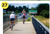
27 PASSERELLES PIÉTONS ET CYCLES AU-DESSUS DE L'AUTOROUTE A5
