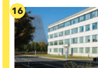
16 IMMEUBLE TRAIT D'UNION
