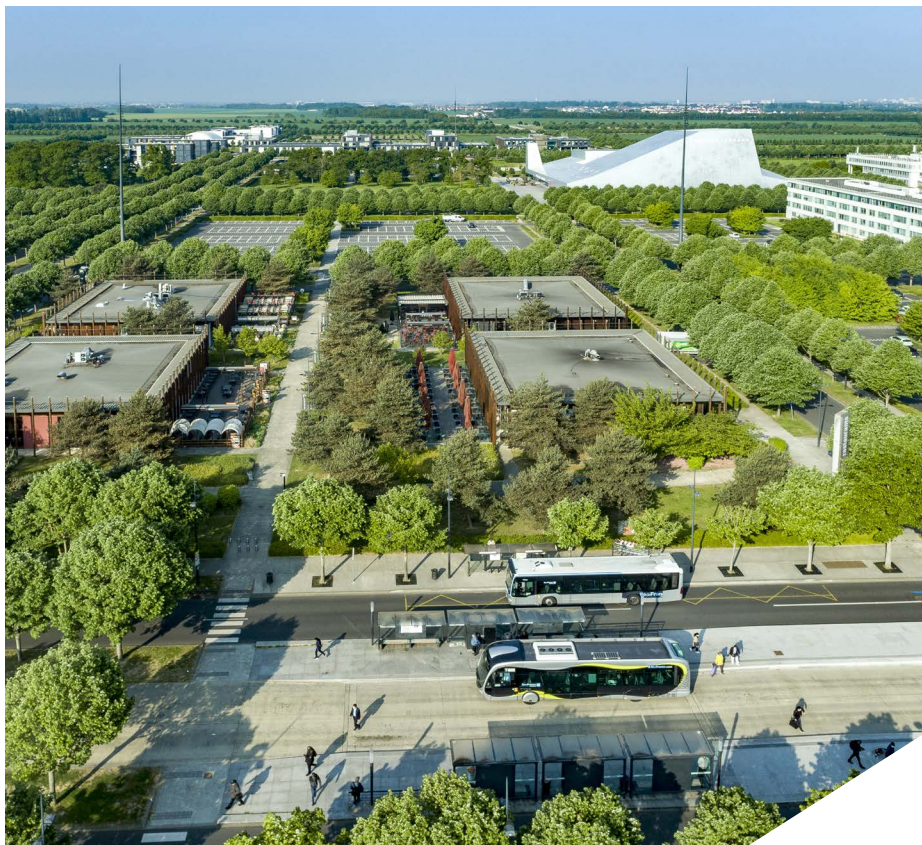
Station du TZen 1 Lieusaint-Corbeil du Trait d'Union, sur le Carré Sénart, Lieusaint (77).
