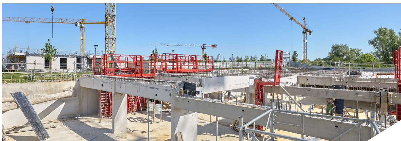
515 logements en cours de réalisation sur la phase II de l'écoquartier de l'Eau Vive, Lieusaint (77).
