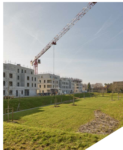
Jardin de gestion des eaux pluviales, Cesson (77).
