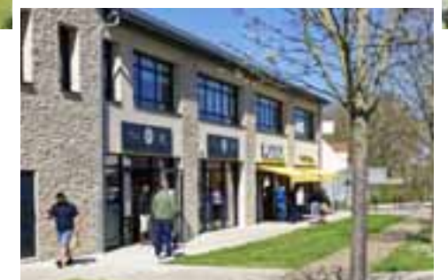
Pôle de restauration, écoquartier de l'Eau Vive à Lieusaint.
