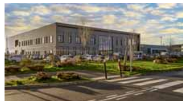
Entreprise Gainerie91 sur le parc du Levant.
