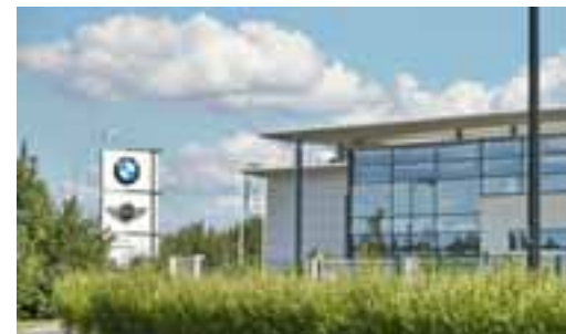
BMW Group France, centre de distribution et de formation.
