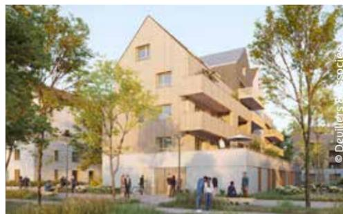
Logements en 3<sup>e</sup> famille avec stationnement réversible en RDC, socle minéral, structure poteaux poutres, ossature et plancher bois, panneaux de remplissage préfabriqués 2D
