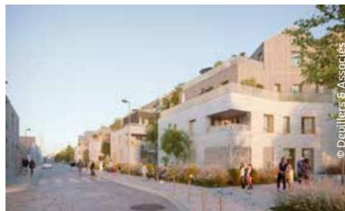
Logements en 2<sup>e</sup> famille avec socle minéral, structure poteaux poutres, ossature et plancher bois, panneaux de remplissage préfabriqués 2D, principe de courtoisie avec le tissu existant
