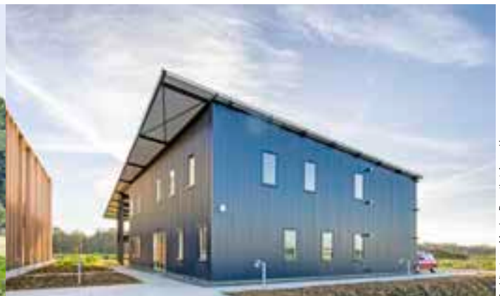
5000 m 2 de locaux d'activités avec bureaux sont développés par Fulton (Livraison de la deuxième tranche en 2016).
