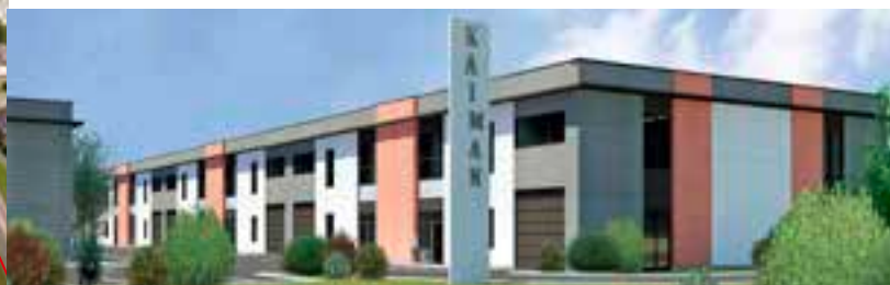
Parc du Levant - KAIIMAN, nouveau programme de locaux d'activités proposés à la location, divisible dès 250 m 2 .
