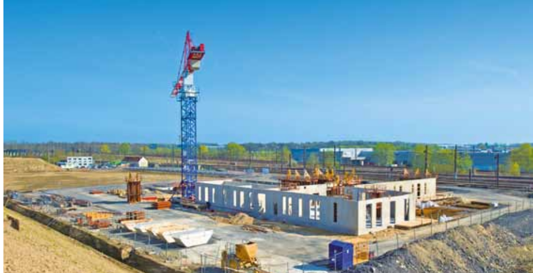
→ Chantier du centre de maintenance du Tzen Lieusaint / Moissy
