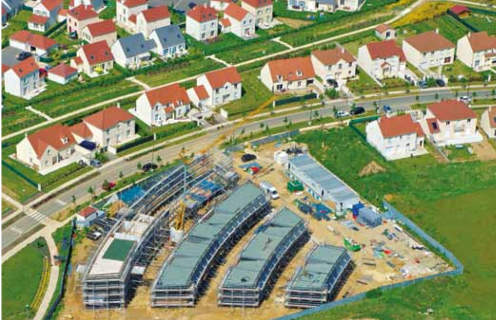
→ Programme FSM à Haute Performance Énergétique, éco-quartier de l'Eau Vive Lieusaint
