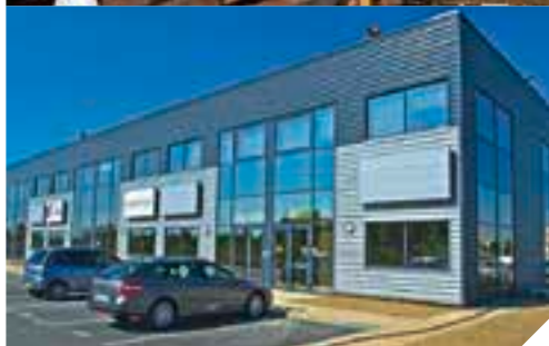
Innovespace, réalisé par ALSEI, 17 000 m 2 d'activités à la location, divisibles à partir de 224 m 2 .
