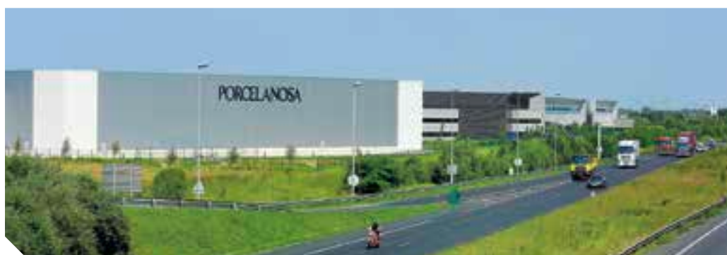
Porcelanosa : siège social France, showroom et centre de distribution
