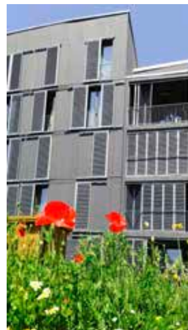
Les bâtiments BuildTog composés de 37 logements sociaux passifs , ont accueilli leurs premiers habitants fin 2014.
